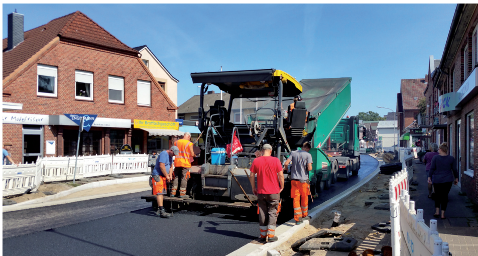
Lange auf der Warteliste, jetzt in Arbeit: Sanierung des Landweges und der Bimöhler Straße
